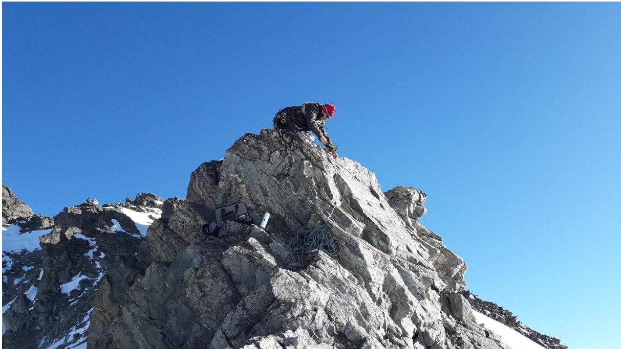
Abbildung 1: Montagearbeiten am Urezzasjoch
