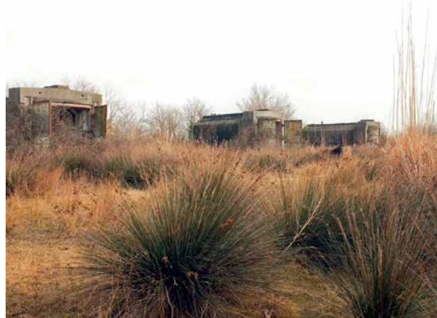
Aufgelassene Militäranlage in Vain, Albanien, 2015 Abandoned military installation in Vain, Albania, 2015
