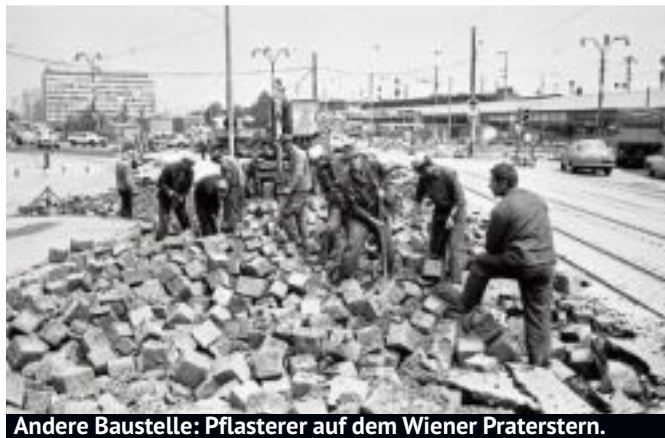
Andere Baustelle: Pflasterer auf dem Wiener Praterstern.
